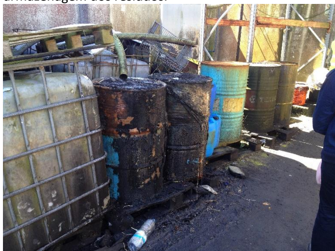
Foto 5 – Armazenagem de óleos minerais usados juntamente com recipientes de óleos alimentares usados, no exterior.
