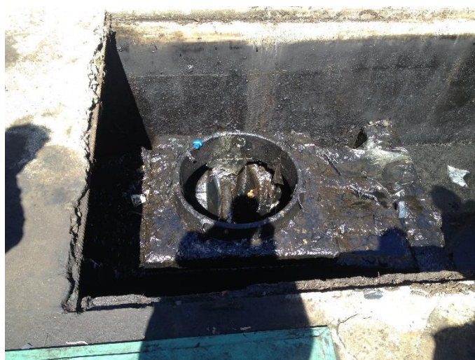
Foto 2 – Separador de hidrocarbonetos.
