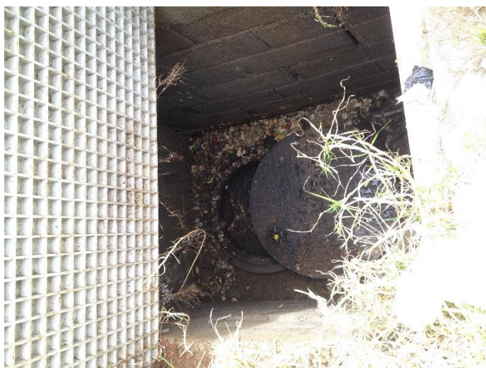
Foto 1 – Separador de hidrocarbonetos.
