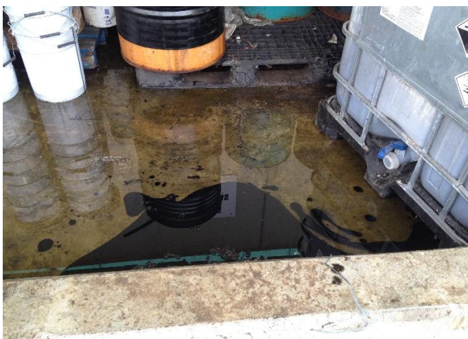
Foto 7 – Derrames na bacia de retenção (da foto 6).
