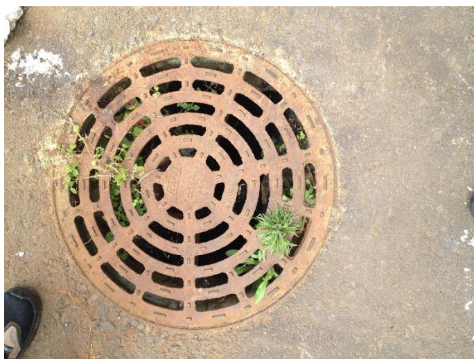
Foto 3 – Poço absorvente S2
