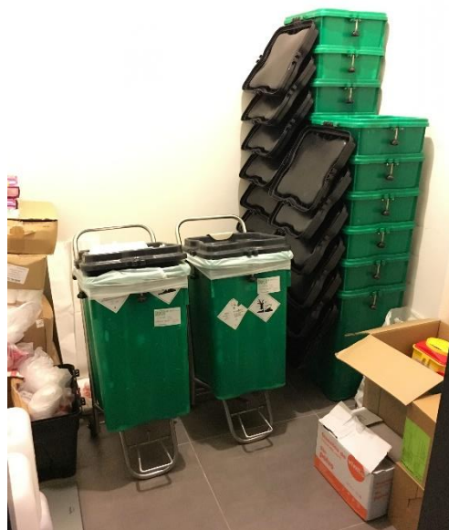
Foto 6 – Sala de armazenamento de contentores limpos, contentores com RH e líquidos de recolha obrigatória sem bacia de retenção.
