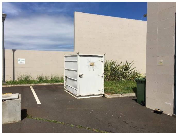
Foto 2 – Zona do contentor sem vedação.
