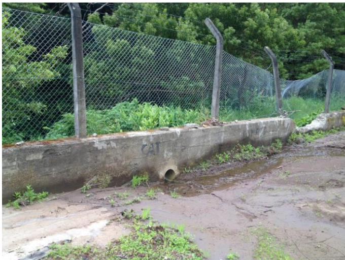
Foto 11 – Muro de vedação na zona de descarga de um afluente na ribeira principal.
