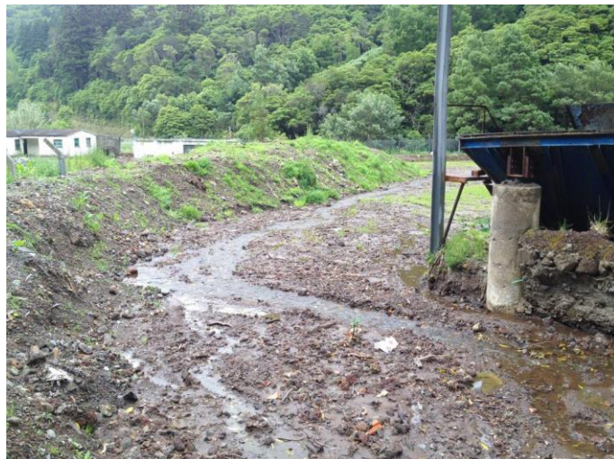
Foto 10 – Talude criado com terras e pedras para orientar os escoamentos (água) para a ribeira.
