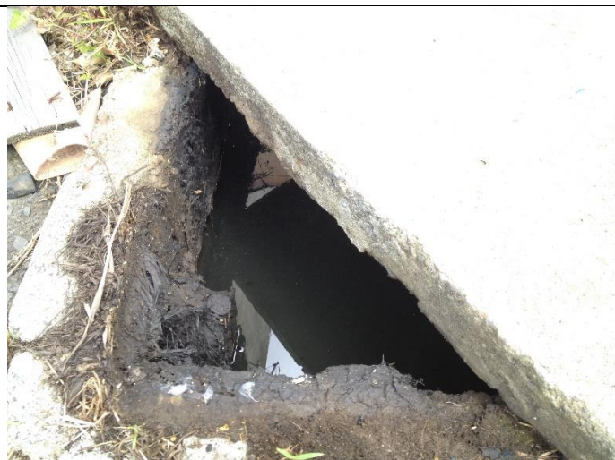
Foto 7 – Caixa de águas residuais ligada a coletor do interior da oficina (contendo águas oleosas).
