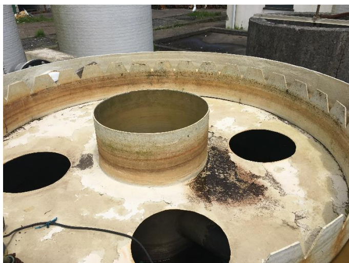
Foto 4 – Aspeto de falta de uso do decantador secundário.
