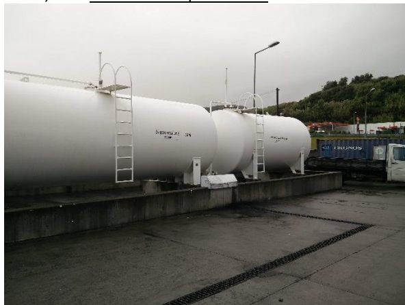
Figura 5: Armazenamento de óleos minerais usados e águas oleosas no exterior, em reservatórios de 35m³ e 25m³, respetivamente, inseridos em bacias de retenção e com rede de drenagem no pavimento.
