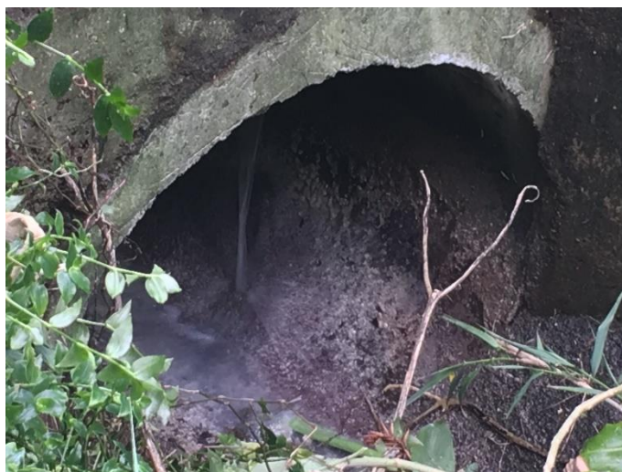
Foto 4 – Descarga do efluente não tratado na linha de água.
