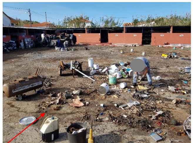
Figuras 2 e 3: Triagem e tratamento de resíduos (perigosos e não perigosos) realizada ao ar livre, em zona não coberta, com o pavimento não impermeabilizado e bastante danificado, sendo visíveis derrames de óleos e outros resíduos líquidos , que se infiltram no solo.
