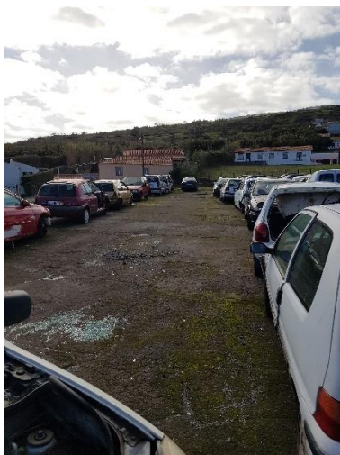
Figuras 14 e 15: Zona de armazenagem de VFV, não impermeabilizada e com o piso bastante danificado, não se encontrando dotada de sistema de recolha e tratamento de águas pluviais e de derramamentos com ligação a decantadores e separadores de óleos e gorduras.
