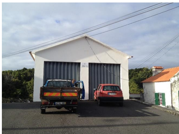
Figura 2: Armazém da Junta de Freguesia de Sto. António.
