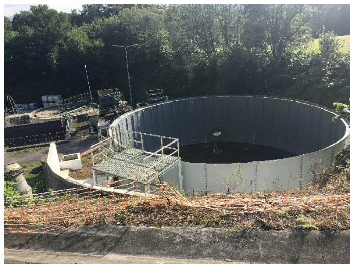
Foto 2 – Tanque de homogeneização após tamisagem na zona da ETARI, sem funcionamento.
