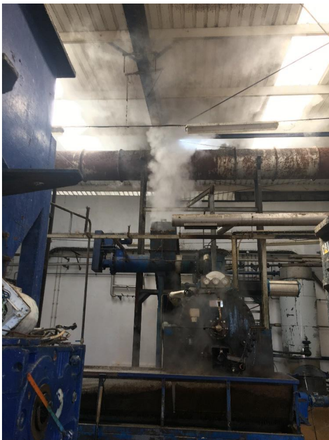
Foto 7 – O sistema de recolha dos gases do sistema de tratamento de subprodutos está inoperante.
