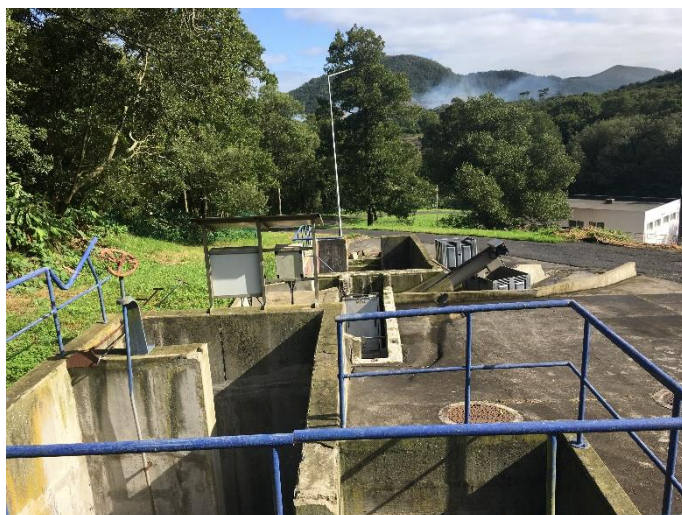
Foto 1 - Sistema de gradagem à entrada da ETARI.
