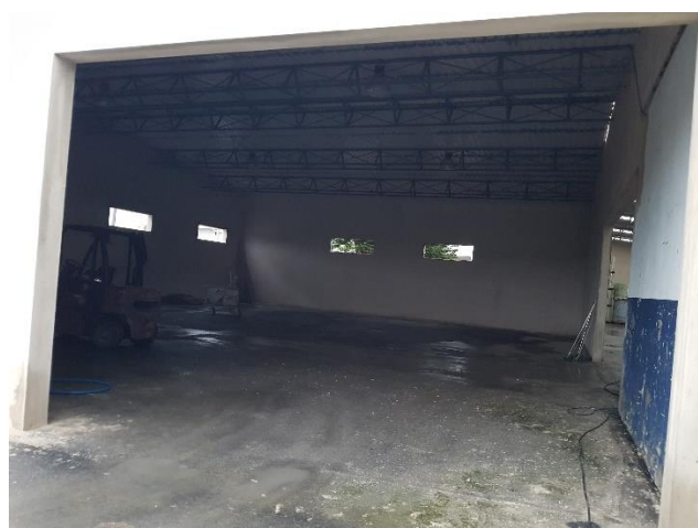
Figura 7: Parque de armazenagem de resíduos.
