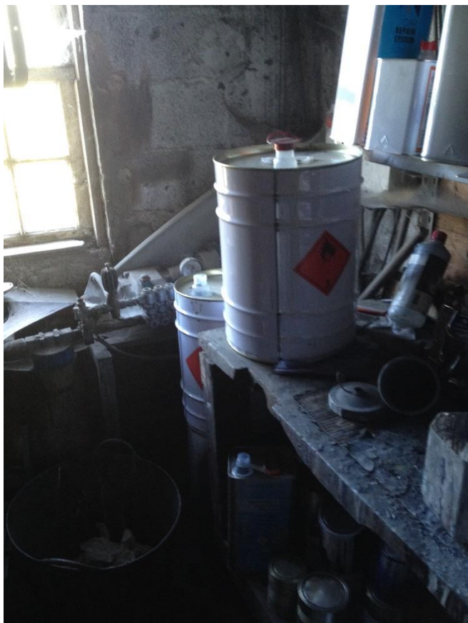
Foto 7 – Armazenagem de produtos químicos (solventes e latas de tinta) no quarto atrás da oficina.
