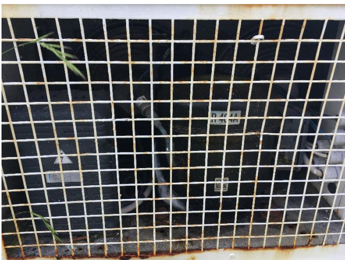
Foto 3 – Compressor do contentor refrigerado.
