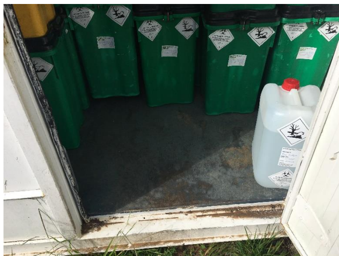
Foto 4 – Contentor sem “caixa estanque com possibilidade de remoção do efluente contaminado”.
