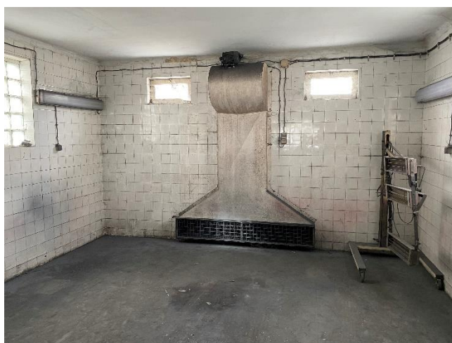
Foto 4 – Sala de pintura, vendo-se ao centro o exaustor.
