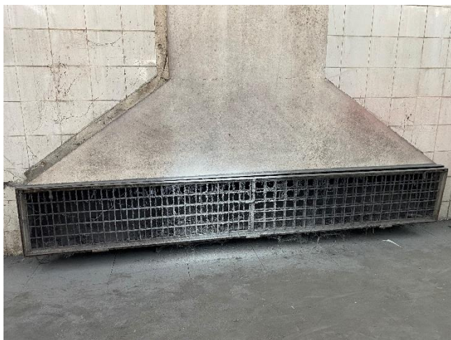
Foto 5 – Aspeto do exaustor, sem filtros.
