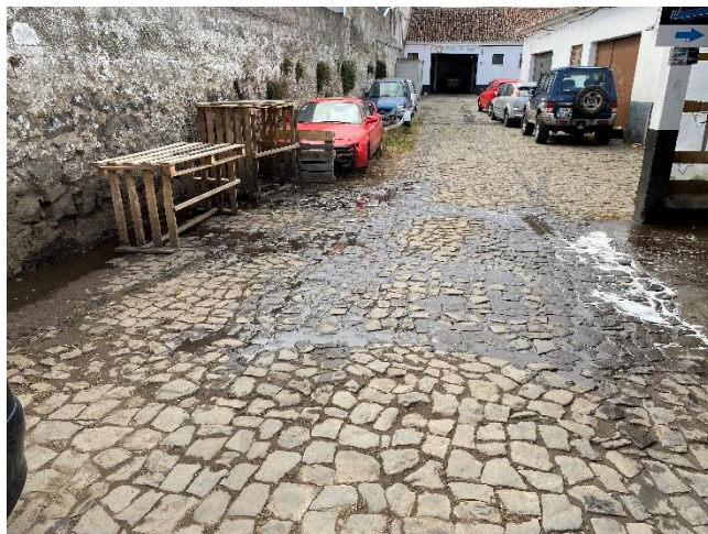
Foto 2 – Águas da lavagem no alpendre escoam para ralo de pluviais.
