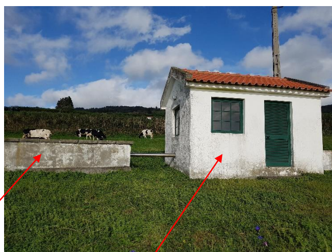
Figuras 3 e 4: Estrutura que contém a captação de água e respetiva casa com o quadro elétrico e comando da bomba.
