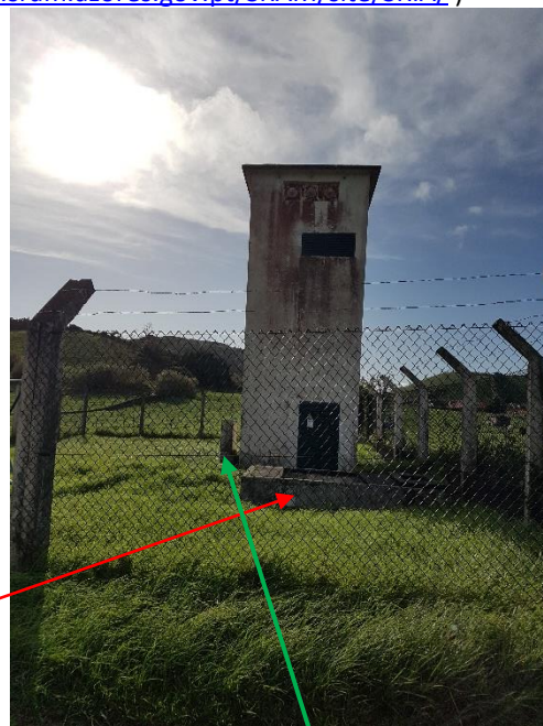
Figuras 3 e 4: Estrutura que contém a captação de água e PT da EDA com o quadro elétrico da captação no exterior.
