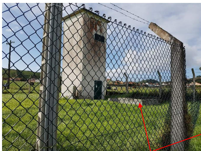
Figuras 3 e 4: Estrutura que contém a captação de água e PT da EDA com o quadro elétrico da captação no exterior.
