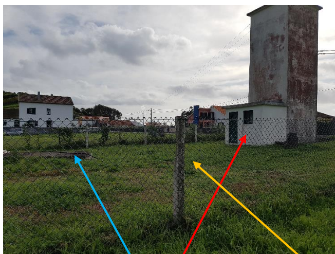
Figura 4: Estrutura que contém a captação de água, respetiva casa com o quadro elétrico de comando da bomba e vedação existente.
