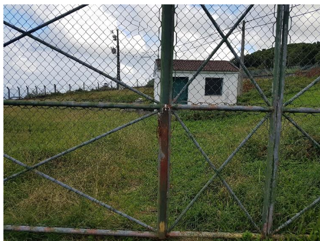
Figura 6: Portão da vedação do Furo de Joana de Alves.
