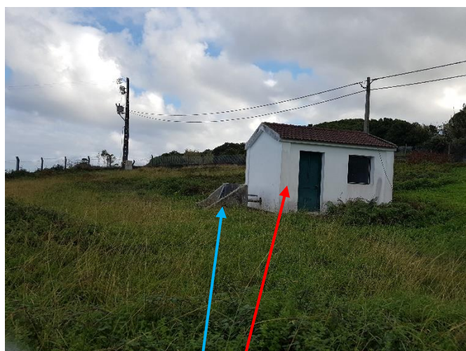
Figura 4: Estrutura que contém a captação de água e respetiva casa com o quadro elétrico de comando da bomba
