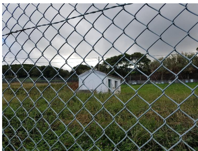
Figura 5: Estrutura que contém a captação de água e vedação existente.
