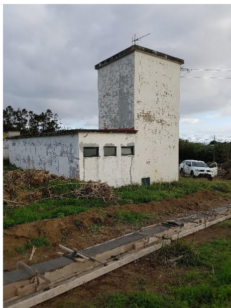
Figuras 6 e 7: Trabalhos da construção da vedação do Furo das Cancelas.
