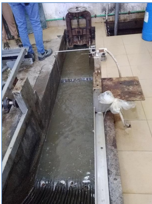
Figura 2.1: Canal de entrada.
