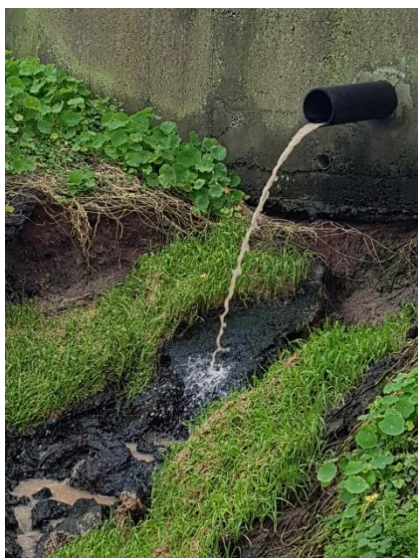
Figuras 2, 3 e 4: Descarga da ETAR da CALF na linha de água (efluente de cor castanha e odor intenso).
