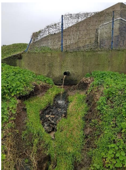
Figuras 2, 3 e 4: Descarga da ETAR da CALF na linha de água (efluente de cor castanha e odor intenso).
