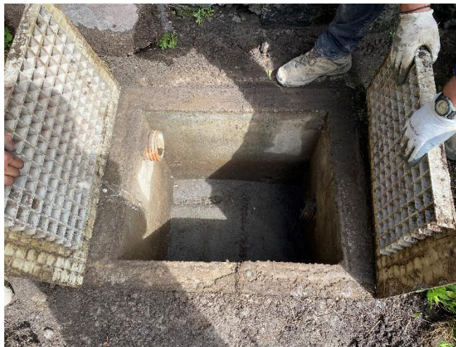
Foto 3 – Caixa de retenção de pó da fabricação de blocos.
