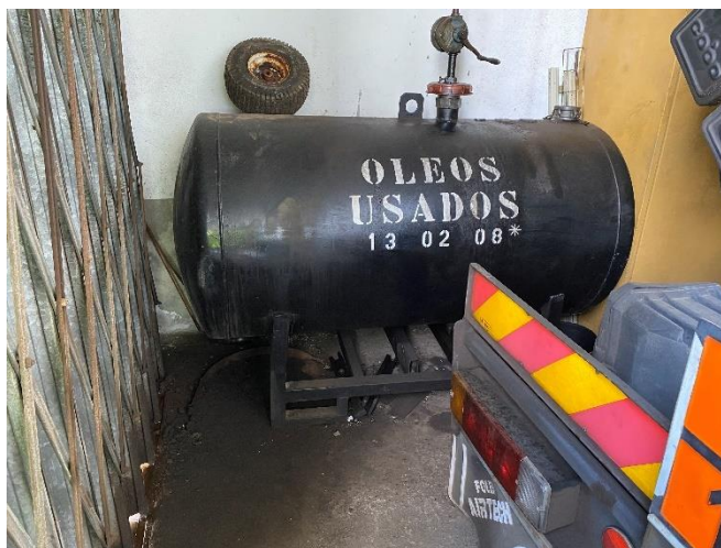
Foto 2 – Reservatório de óleos usados sem bacia de retenção.
