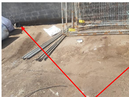
Figuras 49, 50 e 51: Ligação colmatada das águas residuais ao (eventual) separador de hidrocarbonetos.
