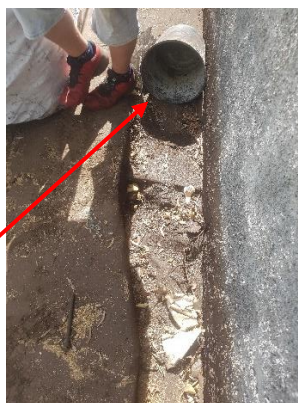
Figuras 49, 50 e 51: Ligação colmatada das águas residuais ao (eventual) separador de hidrocarbonetos.
