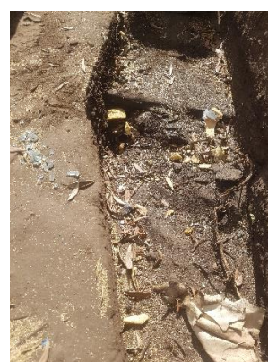
Figuras 49, 50 e 51: Ligação colmatada das águas residuais ao (eventual) separador de hidrocarbonetos.
