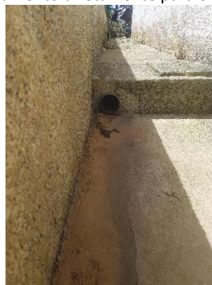
Figuras 4 e 5: Drenagem das águas oleosas e de derramamento diretamente para o solo.
