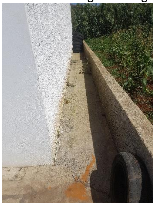
Figuras 4 e 5: Drenagem das águas oleosas e de derramamento diretamente para o solo.
