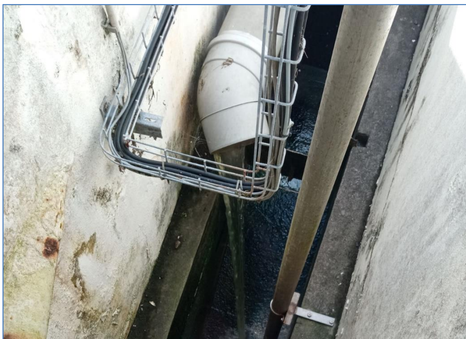
Figura 2.3: Descarga do efluente à entrada do emissário.
