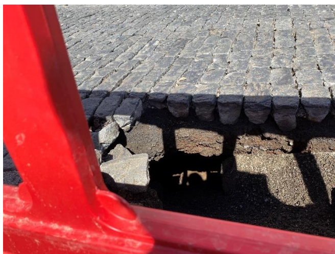
Foto 2 – Pormenor da estrada na zona da ruptura da conduta.
