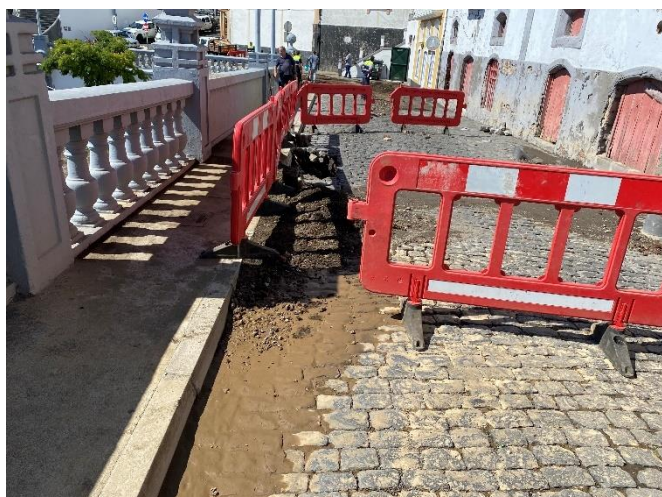
Foto 1 – Zona da ruptura da conduta da estação elevatória.
