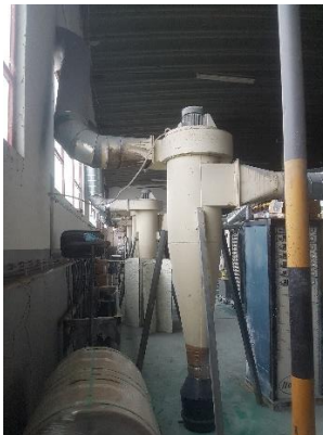
Figuras 5 e 6: tubagem de exaustão da cabine de pintura e ciclone coletor de pó de tinta.
