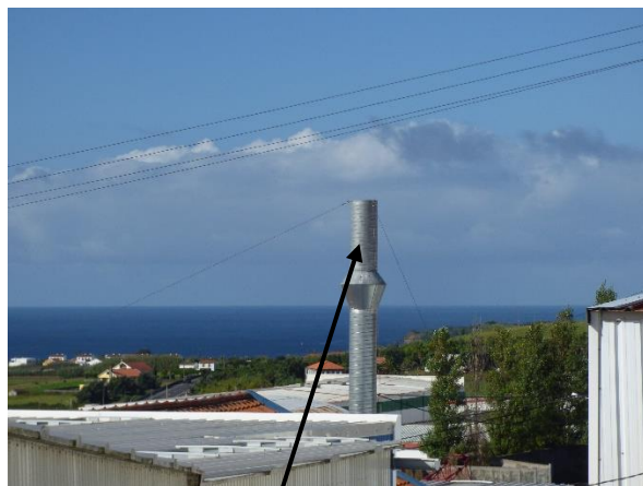
Figura 3: Fonte de emissão fixa da cabine de decapagem e metalização .
