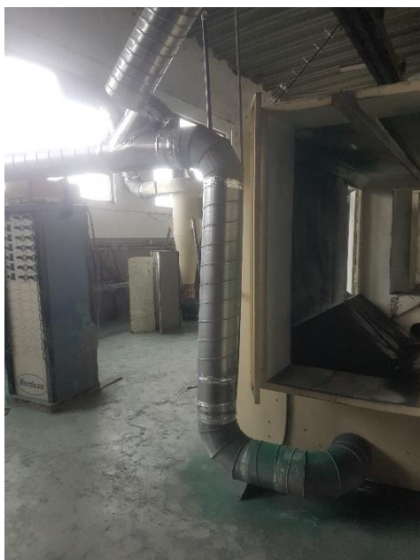
Figuras 7 e 8: cabine de pintura e respetivo exaustor com vestígios de tinta verde.
