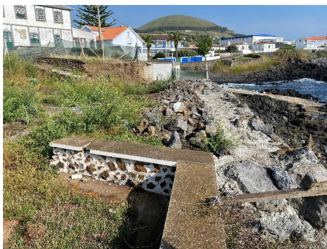
Foto 2 – Muro de suporte em construção.
