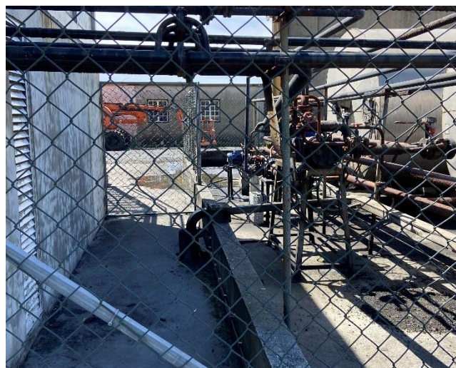
foto 12-Bacia de retenção da central de betuminoso não eficaz. Danificada, com fissuras na base da parede de contenção.
