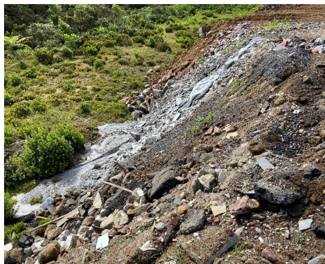
foto 6- Alteração da topografia com mistura de RCD.
