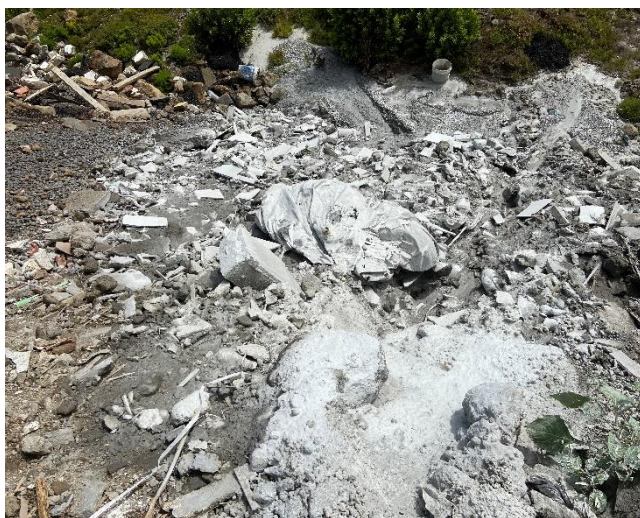
foto 5- Alteração da topografia com mistura de RCD.
