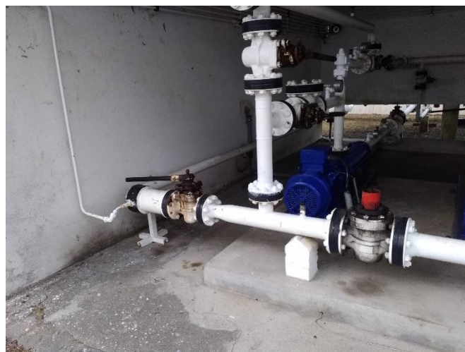
Foto 2 – Pormenor de cabo de ligação terra desprotegido.
