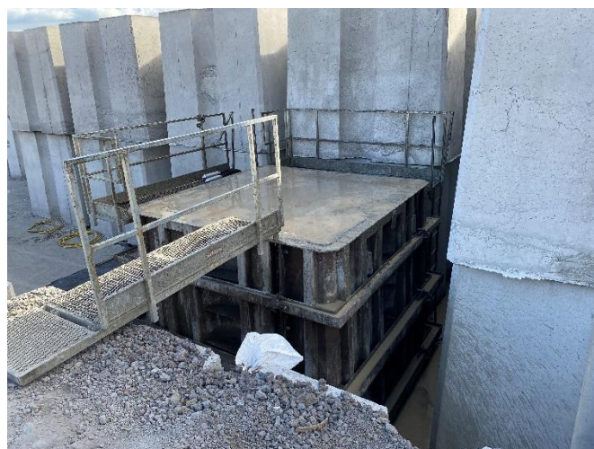
Foto 4 – Fabricação de um bloco antifer de 460 kN.
