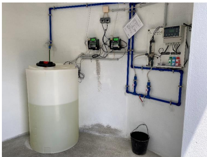
Foto 2 – Reservatório de cloro para cloração da água.
