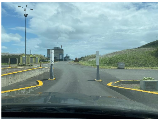
Foto 1 – Pórtico para deteção de fontes radioativas.
