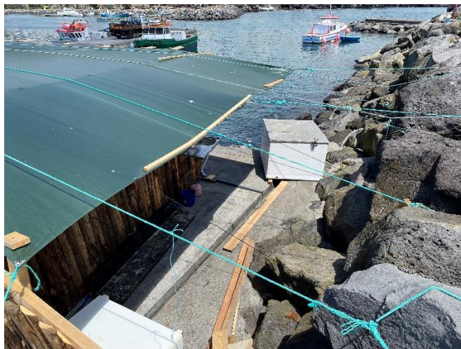
Foto 2 – Caleira de drenagem de águas pluviais e zona da descarga no mar.
