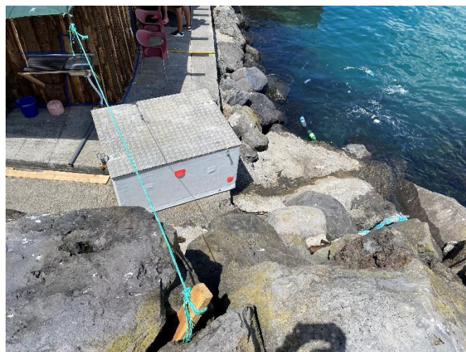
Foto 4 – Zona da descarga da caleira (para onde estão ligadas as tubagens de todas as pias instaladas nas três tascas instaladas no porto).
