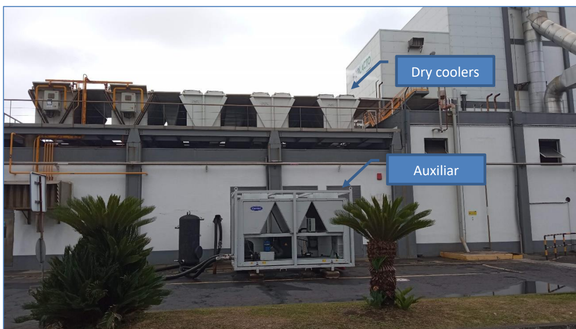
Figura 2.4: Sistema de refrigeração auxiliar.
