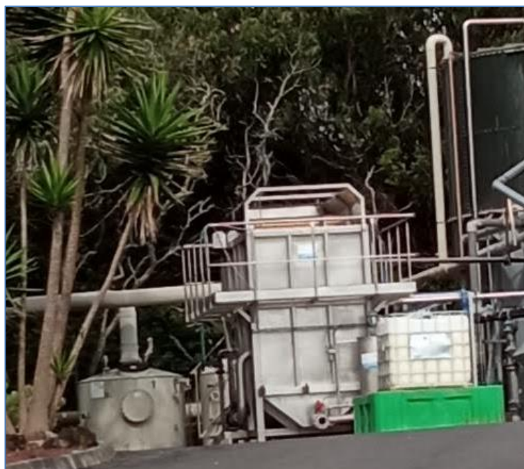
Figura 2.2: Flotador (DAF).
