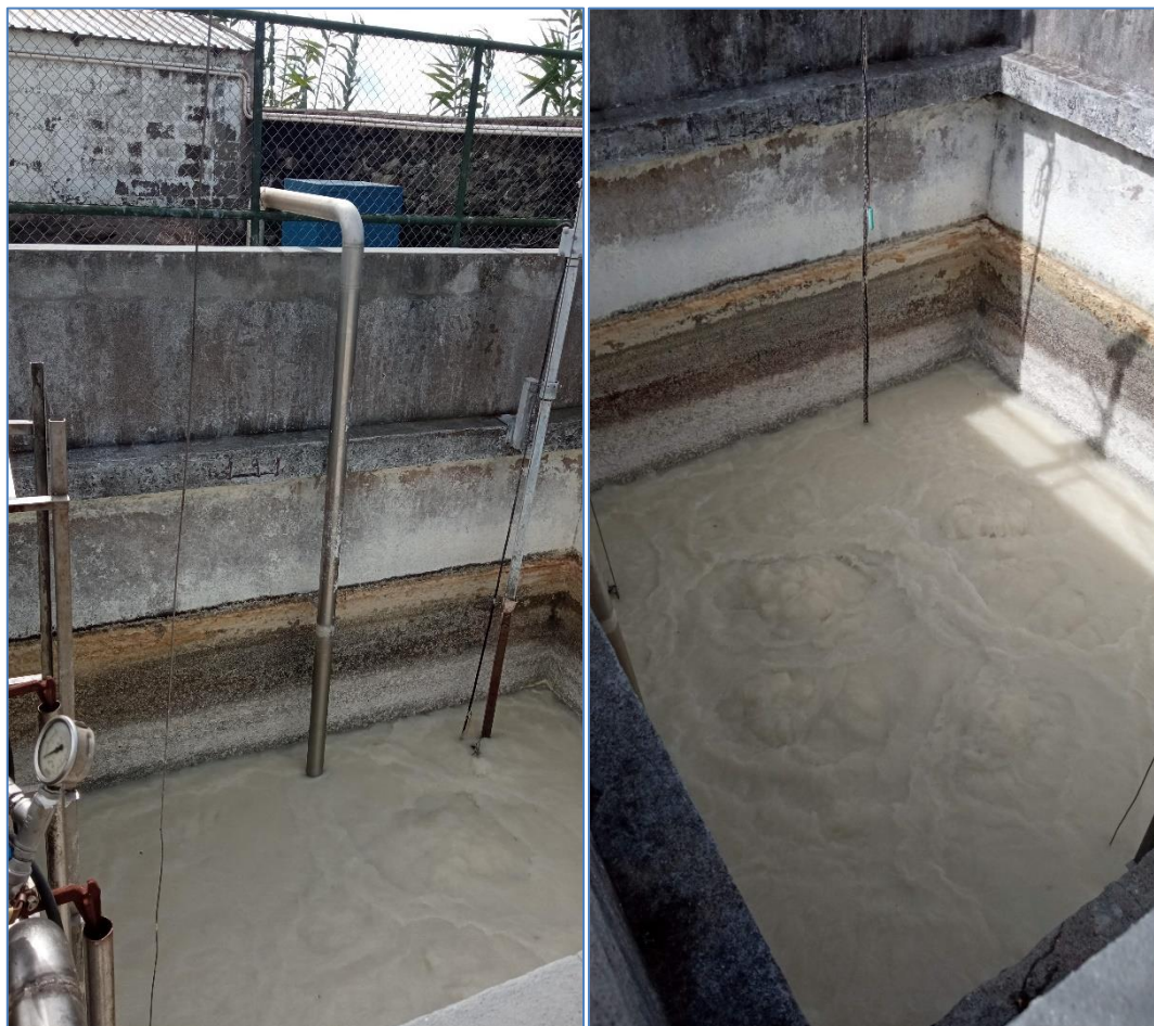
Figura 2.1: Sistema de arejamento instalado no tanque de receção.
