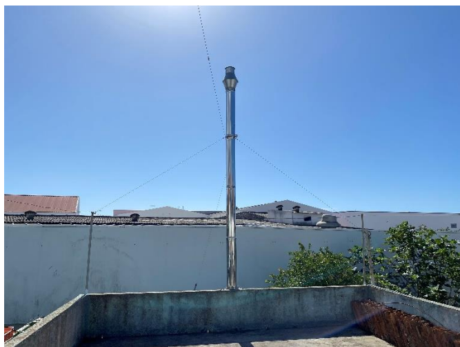
Foto 1 – Nova chaminé instalada na cabine de pintura.
