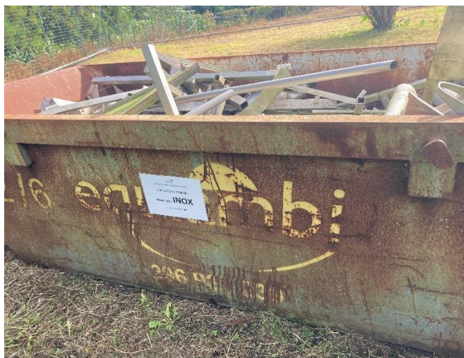
Foto 1-Contentor INOX 17 04 07, deveria ser 17 04 05. Foto 2-Mistura de partes de REEE com metais.
