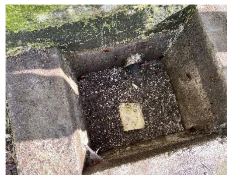
Foto 4 – Sumidouro da bacia de retenção dos óleos
