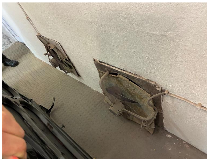
Foto 7 – Parte do sistema de extração sem manutenção e funcionamento parcial Foto 8 – Mistura de resíduos resultantes da pintura.
