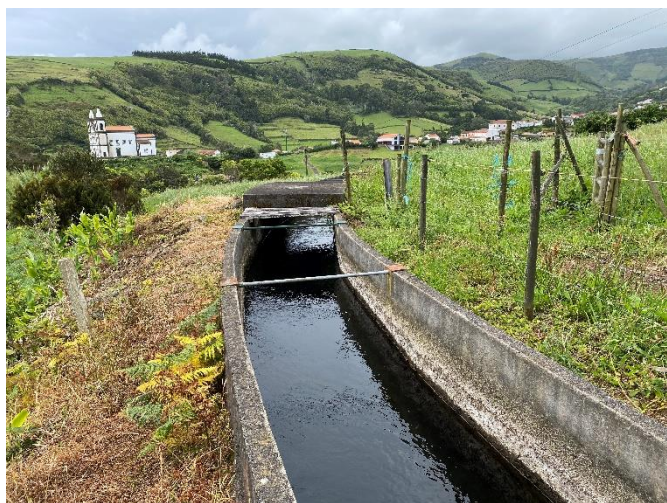
Foto 5 – Canal de adução.
