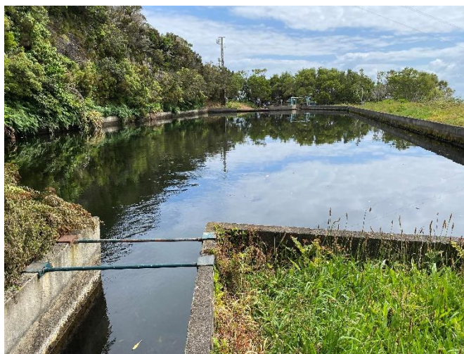
Foto 6 – Câmara de carga.
