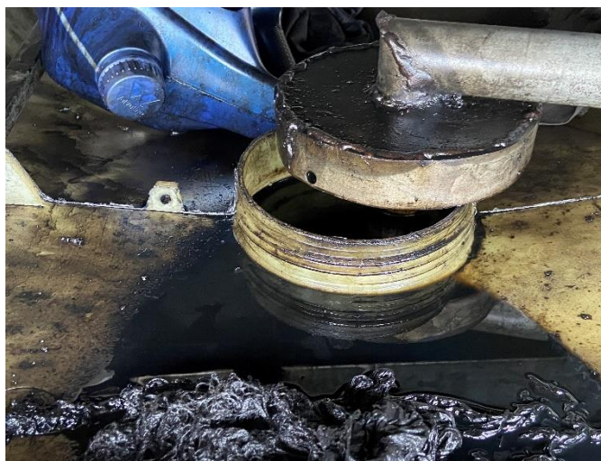
Foto 5 – Contentor de armazenamento de óleo usado sem identificação, cheio e a verter.
