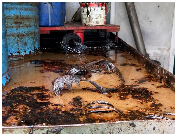
Foto 6 – Bacia de retenção com água que cai dos buracos do teto contaminada com hidrocarbonetos.
