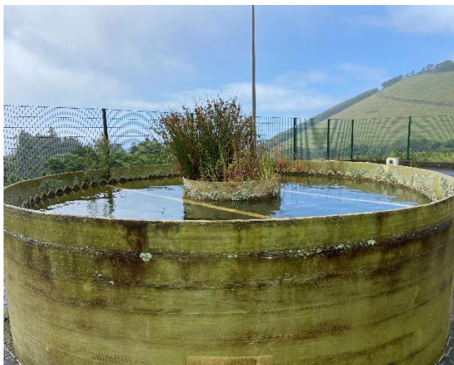
foto 3- Decantador da ETAL sem funcionar.
