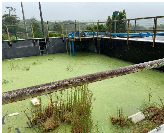
foto 2- Tanque de arejamento da ETAL sem funcionar
