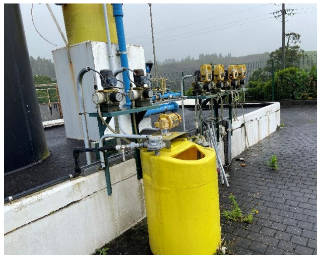
foto 4- Sistema de adição de produtos químicos, sem os componentes de armazenamento.
