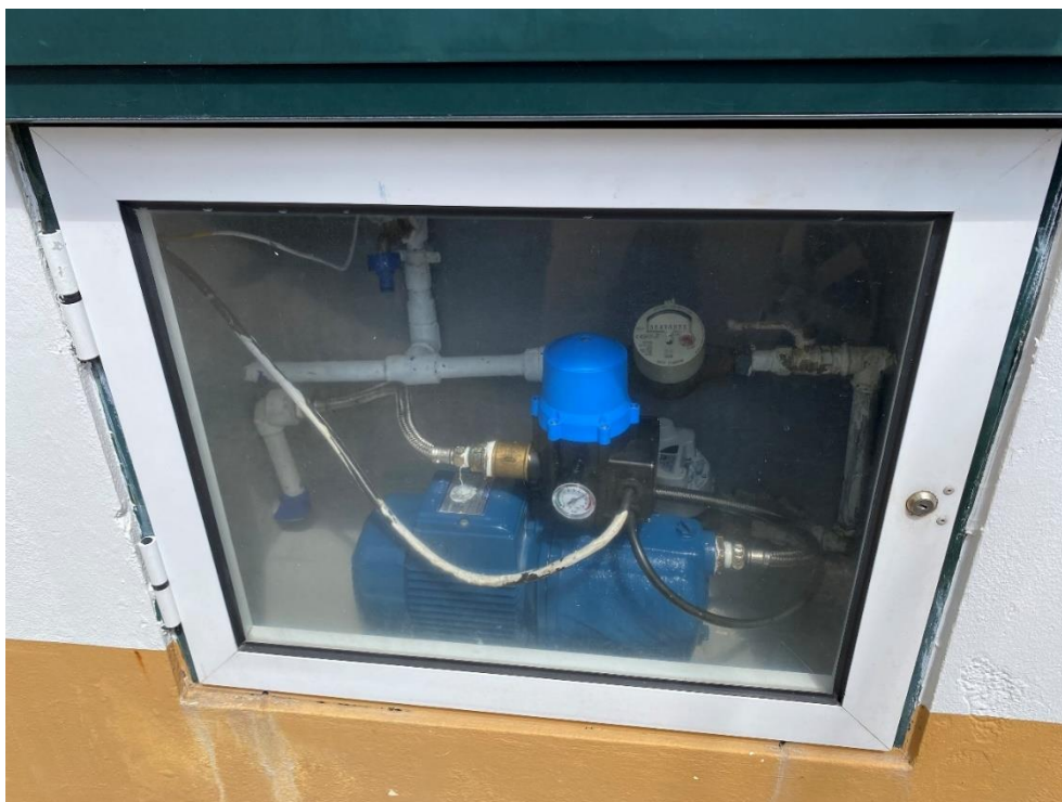
Foto 1 – Bomba de água sem isolamento da vibração.
