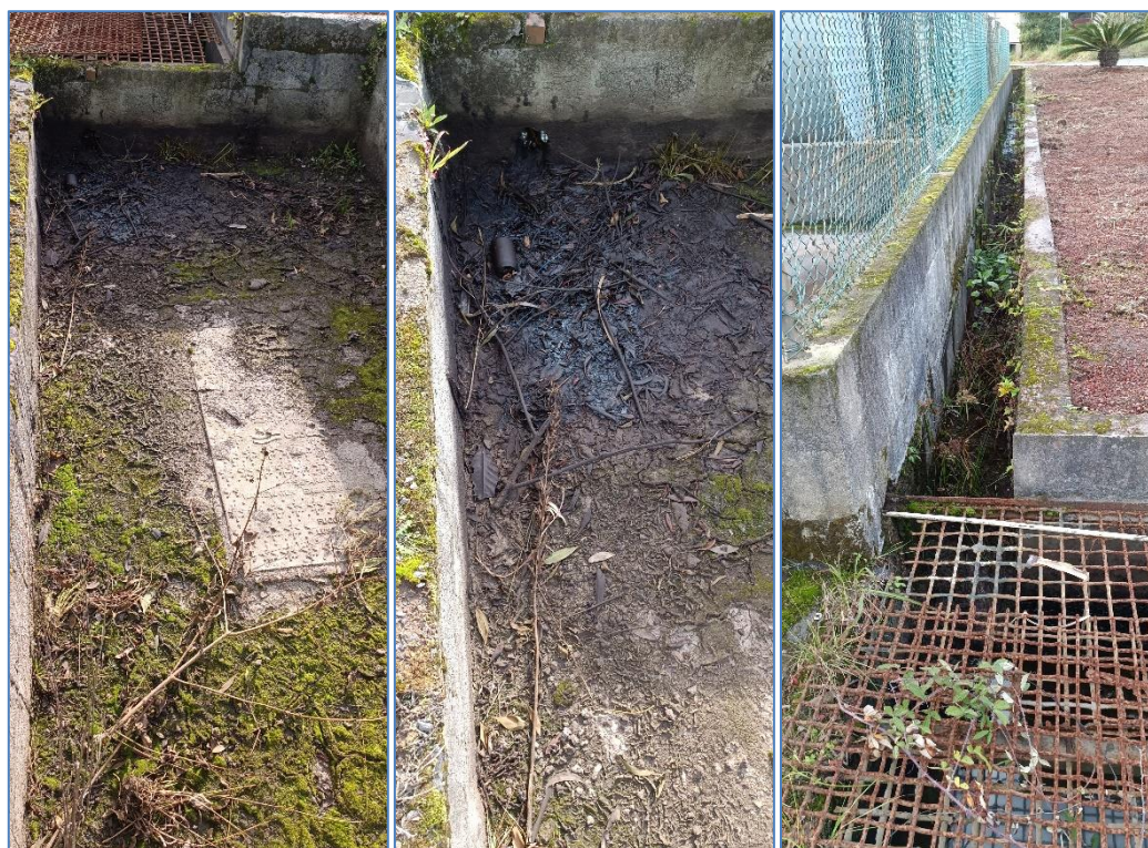
Figura 4.2: Zonas do sistema de drenagem e tratamento a necessitarem de limpeza.
