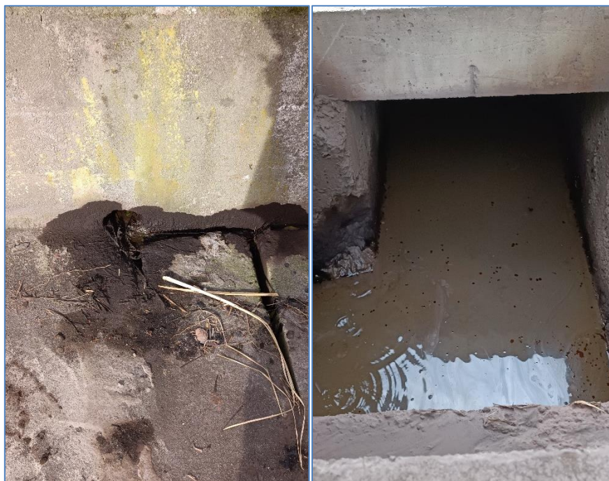
Figura 4.1: Furo na bacia de retenção e acumulação de águas oleosas na caleira.
