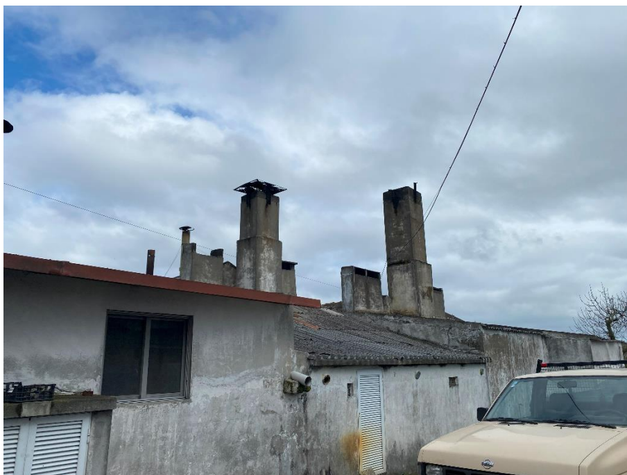
Foto 2 – Vista de diversas chaminés dos fornos tradicionais.
