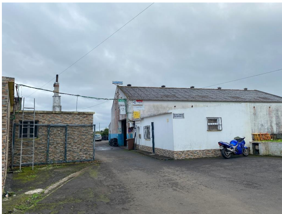
Foto 1 – Vista da chaminé de um dos fornos anelares.
