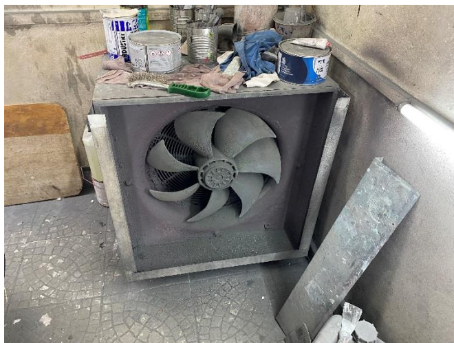
Foto 2 – Exaustor no lado direito da câmara de pintura.
