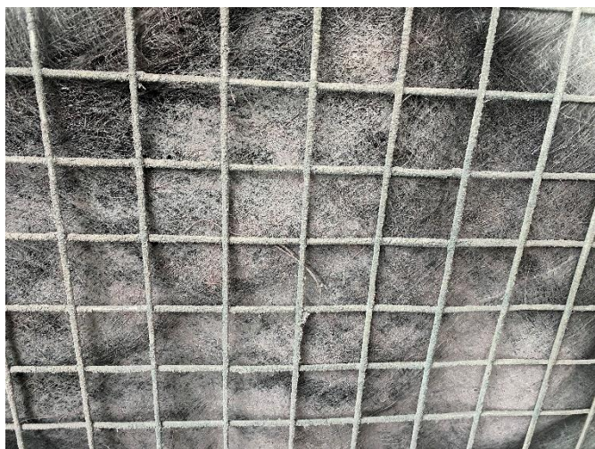
Foto 3 – Aspeto do filtro carregado de partículas (no exaustor esquerdo).
