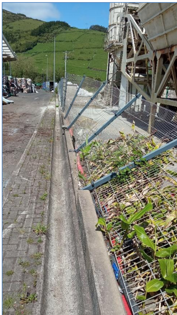
Figura 5.5: Vedação danificada.
