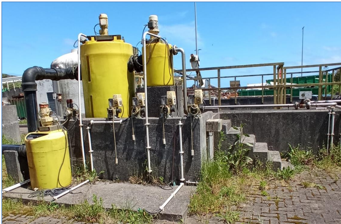
Figura 4.3: Equipamentos de doseamento e mistura para o tratamento físico-químico (sem reagentes).
