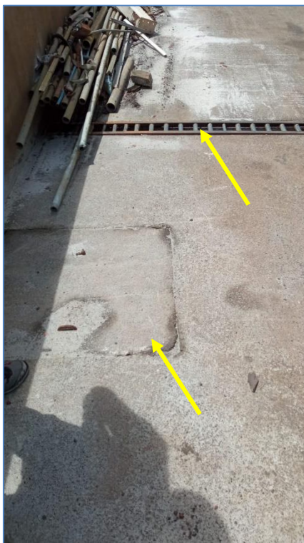
Figura 4.1: Local de lavagem de máquinas (grelha de recolha de águas e tampa do separador).
