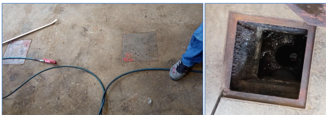
Figura 5.3: Tampas de acesso aos reservatórios de óleos usados (imagem da esquerda). Tampa de acesso aberta (imagem da direita).
